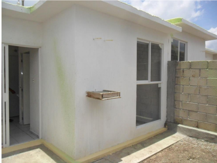
FOTO 1. Fachada de la vivienda
